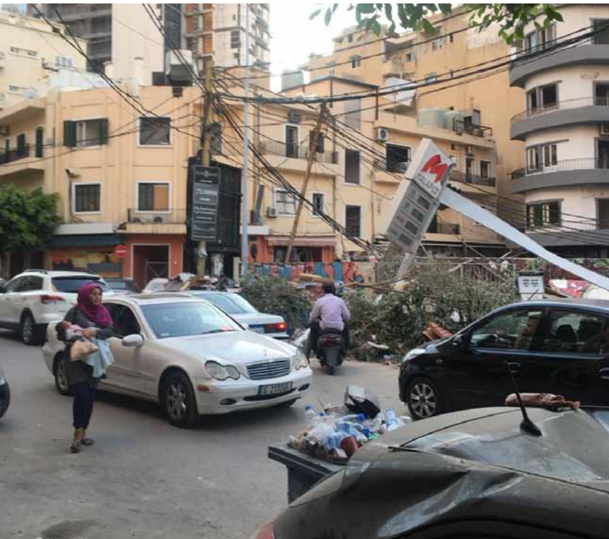
Bensa-asema päivänhintatorneineen on osin romahtanut ja johdot ovat sekaisin.
